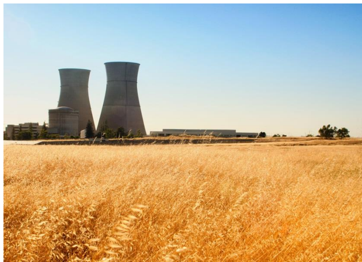
Centrale nucléaire (Toutes les sources des images sont à l'annexe 3.)
